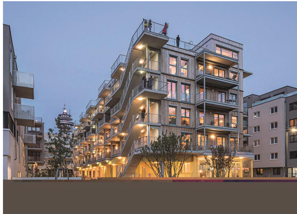
einszueins architektur Gleis 21 Wien
